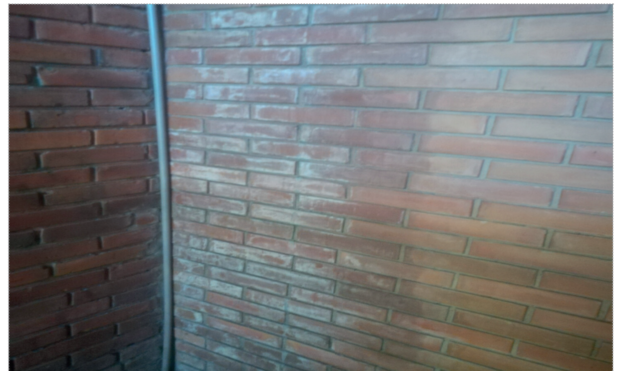
Foto N° 6: Área del bloque 1, donde se observa la humedad en la pared del entre piso.
